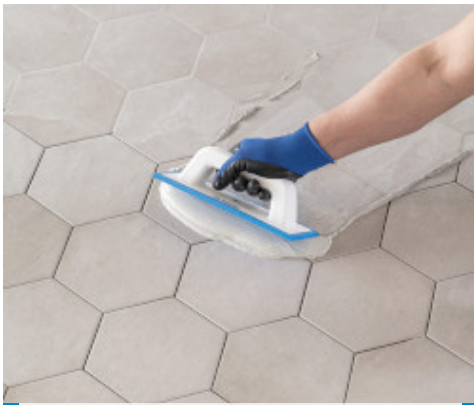
Rejuntado de revestimiento de mosaico vítreo (en baño) con llana
